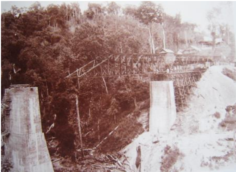
การก่อสร้างสะพานเหล็กข้ามลำคลองเพื่อวางรางรถไฟในถิ่นทุรกันดาร
