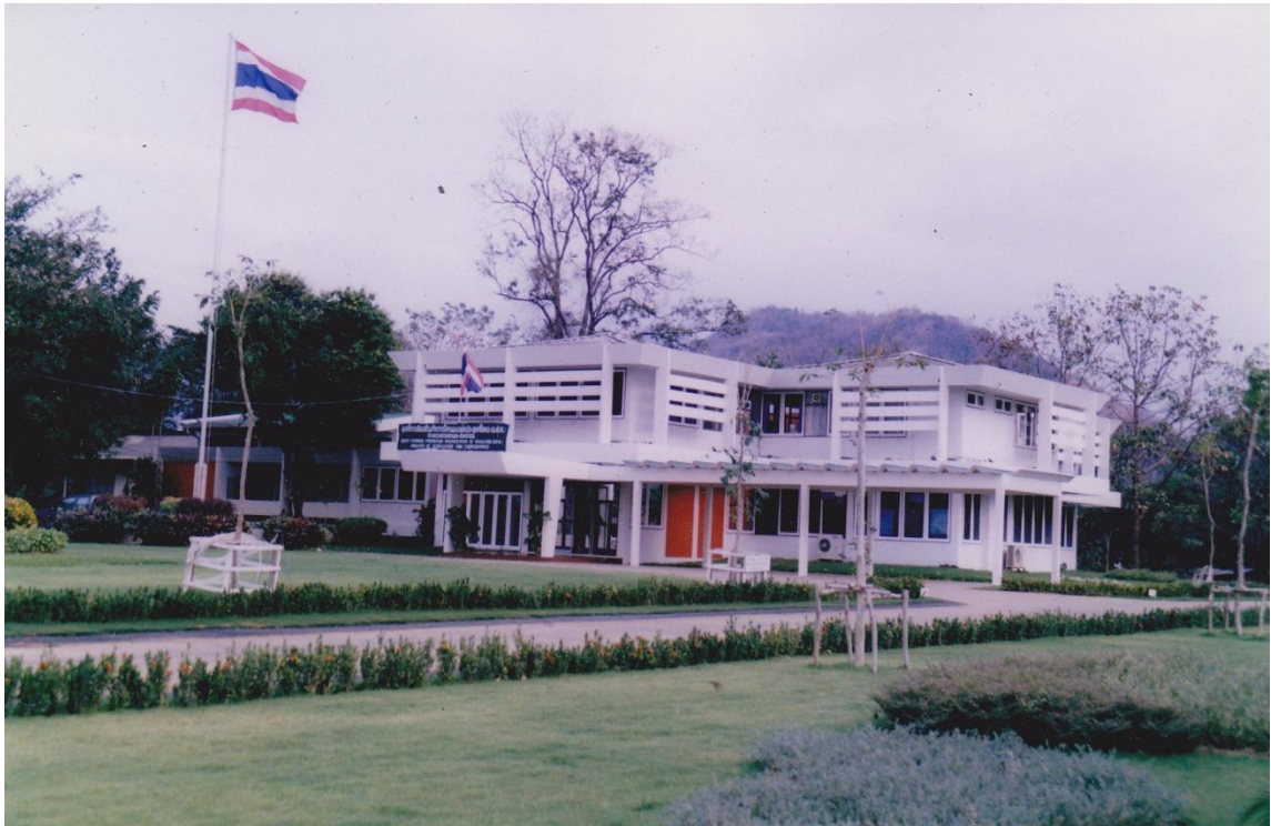
สำนักงานกลาง อ.ส.ค. อำเภอมวกเหล็ก จังหวัดสระบุรี ก่อนการปรับปรุง
