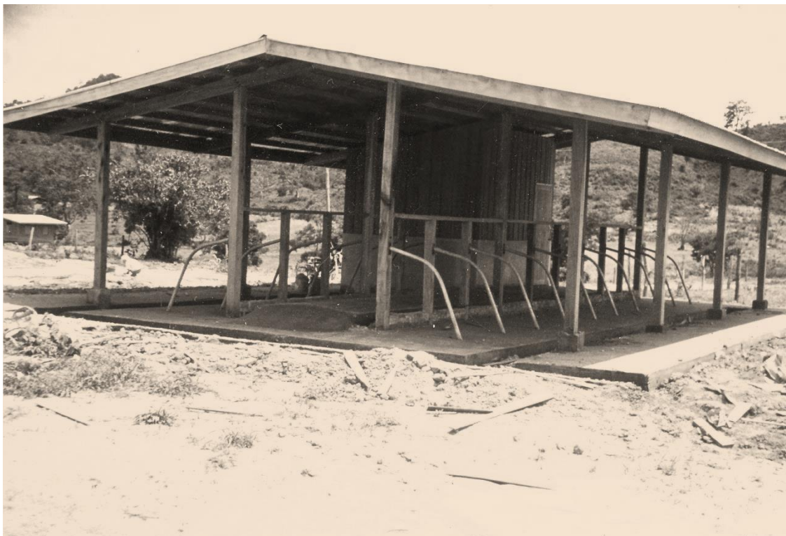
คอกโคของเกษตรกร บนพื้นที่ 25 ไร่ ที่ได้รับจัดสรรในนิคมสร้างตนเองผู้เลี้ยงโคนม อำเภอมวกเหล็ก จังหวัดสระบุรี
