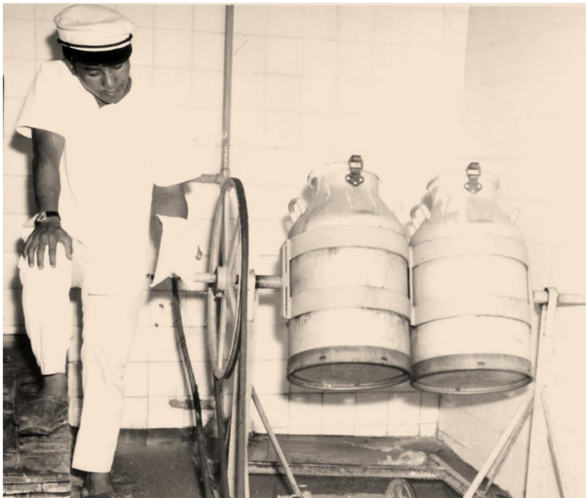
เครื่องทำเนยแบบประยุกต์ ... โดยใช้ถังบรรจุนมขนาด 40 ลิตร และมอเตอร์ไฟฟ้าขับเคลื่อน ประดิษฐ์โดยช่างแมคคานิคของฟาร์มโคนม เริ่มผลิตเนยสดบรรจุอูมีเนียมฟอสฟอรัส ขนาด 250 กรัม ออกสู่ตลาด
