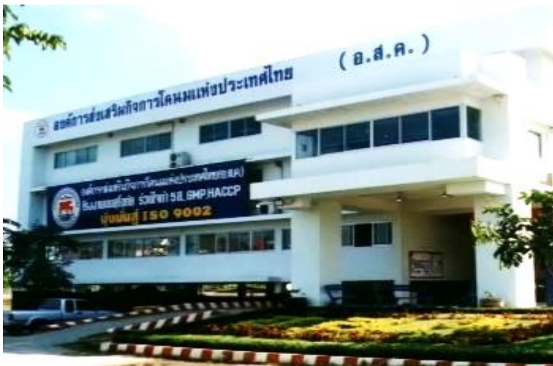
โรงงานสุโขทัย .. ตั้งอยู่ที่ นิคมสหกรณ์สวรรคโลก ต.คลองมะพลับ อ.ศรีนคร จ.สุโขทัย ก่อสร้างเมื่อปี พ.ศ.2541 ดำเนินการผลิต พ.ศ.2542 กำลังการผลิต 60 ตัน/วัน
