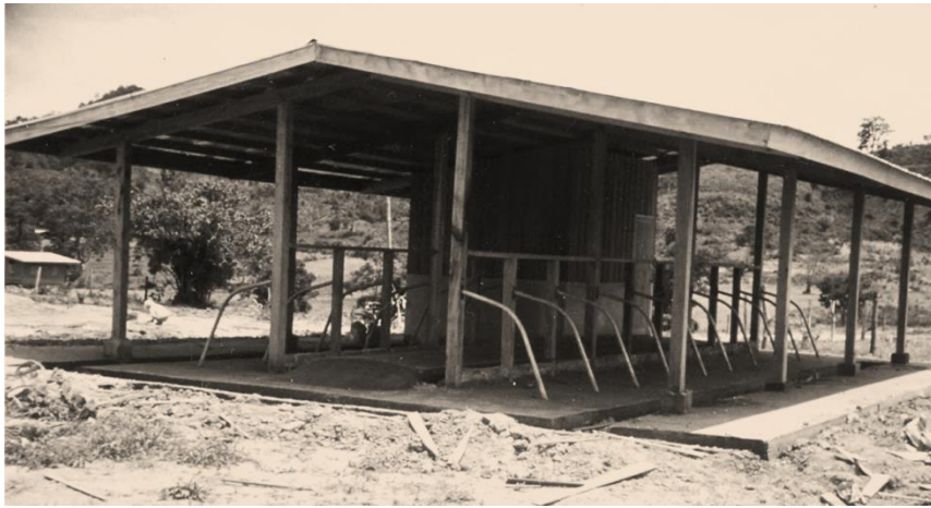
บ้านพักและคอกโคของเกษตรกร บนพื้นที่ 25 ไร่ ที่ได้รับจัดสรร ในนิคมสร้างตนเองผู้เลี้ยงโคนม อำเภอมวกเหล็ก จังหวัดสระบุรี
