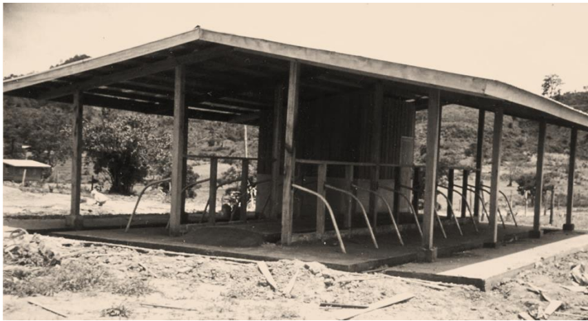
บ้านพักและคอกโคของเกษตรกร บนพื้นที่ 25 ไร่ ที่ได้รับจัดสรร ในนิคมสร้างตนเองผู้เลี้ยงโคหม อำเภอแมกเหล็ก จังหวัดสระบุรี
