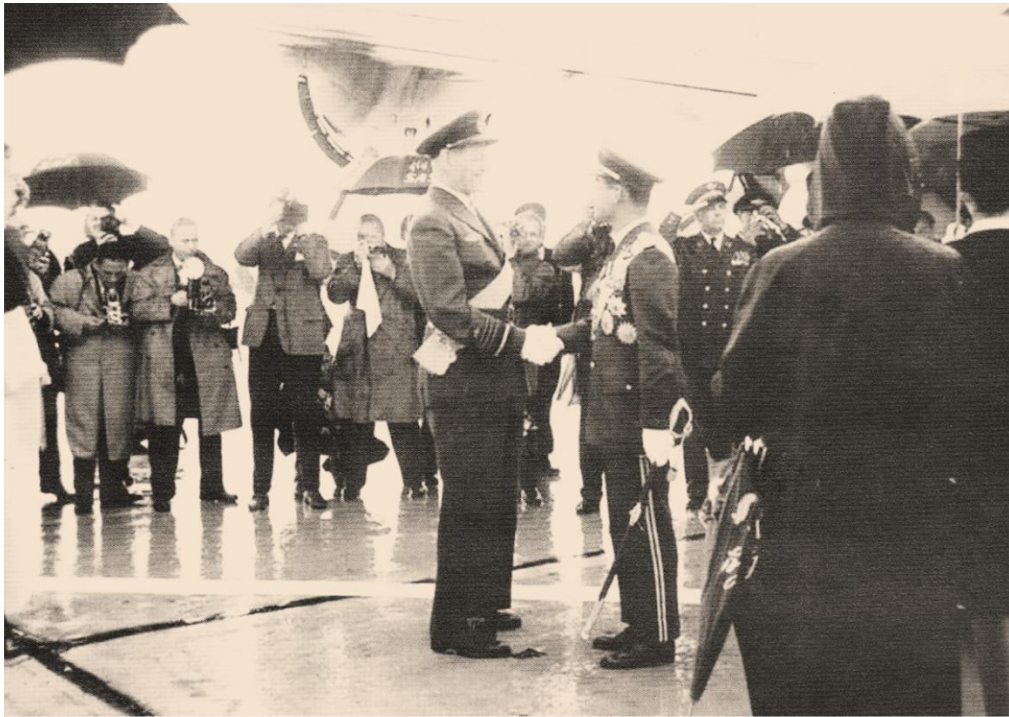
พระบาทสมเด็จพระเจ้าอยู่หัวฯ และพระบรมราชินีนาถ เสด็จฯ โดยเครื่องบินพระที่นั่ง ถึงท่าอากาศยาน Kastrup กรุงโคเปนเฮเก้น ประเทศเดนมาร์ก
