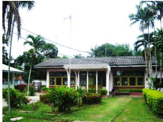
อาคารศูนย์เด็กฯ หลังที่สาม สร้างขึ้นระหว่างปี 2533 - 2534
